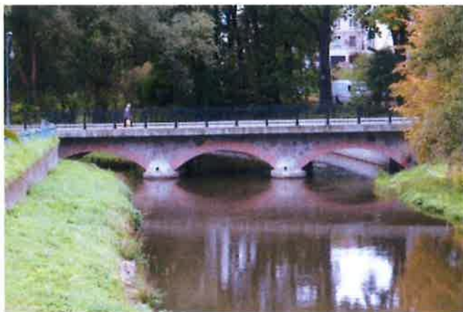
Zdjęcie nr 17. Most drogowy, ciąg ulic Reja-Kopernika
